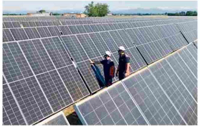
Tecnici al lavoro in un impianto fotovoltaico
